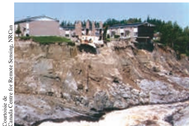
Glissement de terrain (Saguenay, 1996)
